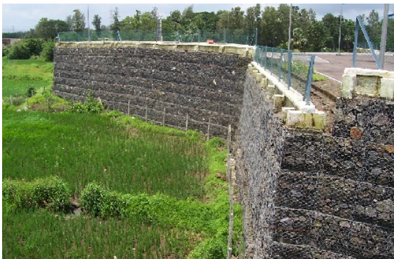
चित्र-5 Actual Gabion wall at site
